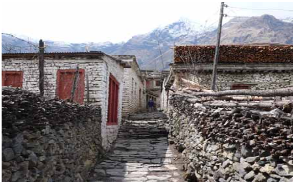
集落内のメイン道路 石を敷詰め地形に合わせる
