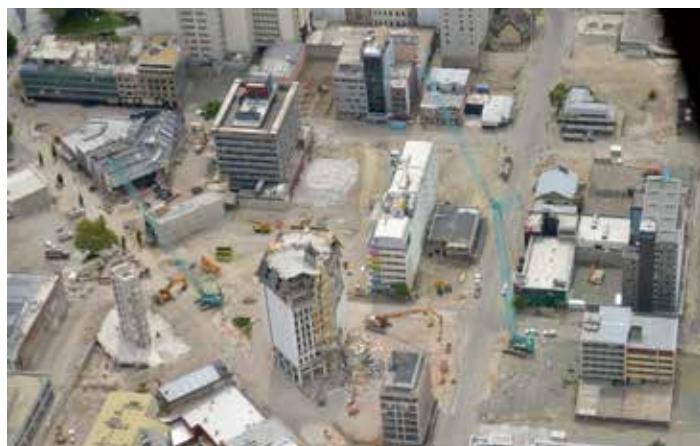
建物の解体が続く中心市街地のレッドゾーン (2015) https://www.theconstructionindex.co.uk
