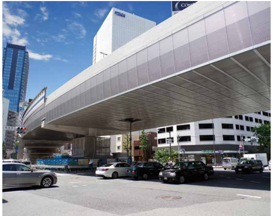
写真：首都高速道路3号線神泉町交差点の恒久足場
