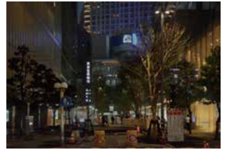
【千代田区道136号線（工事中）：左_1987年の街路灯（消灯）、右_今回整備された形を主張しない街路灯】
