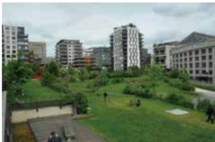
国立図書館周辺に建設された新しい建築群と公園
