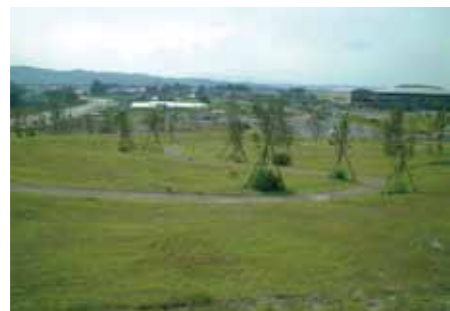
県道と同一勾配で整備され、隣接公園との一体的利用が可能な磐井川緩傾斜堤防
