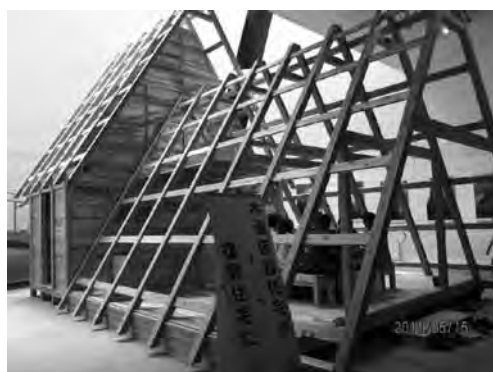
木造仮設住宅・合掌の家(オークヴィレッジ木造建築研究所)
