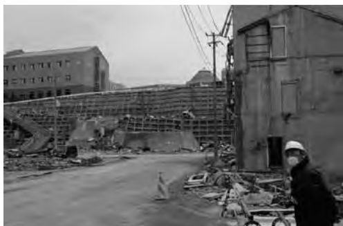
左上の病院の1階 が津波で被災した (女川町)
