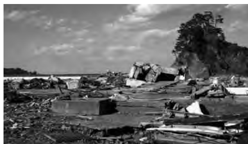
岩泉町：防波堤のアンコ部分は砂・土。これではすぐ壊れる
