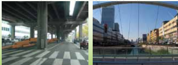
清溪川 左/旧高速道路高架 右/復元した現在
